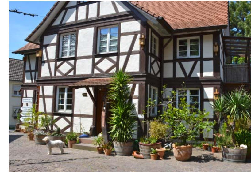
Das Wohnhaus der Familie sieht alt aus, ist aber ein Neubau. Heinrich Gretzmeier hat mit Materialien gebaut, die man auch vor 400 Jahren verwendet hätte
